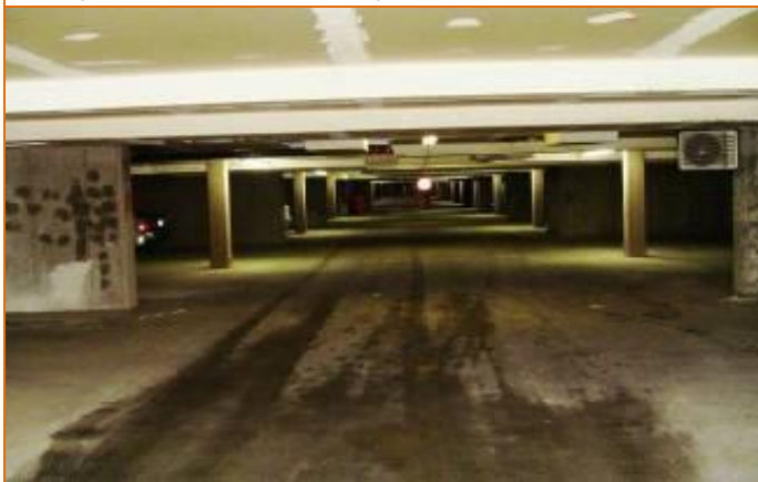
Parking immeuble "Les RIVES DU ST-LAURENT" - 2006
